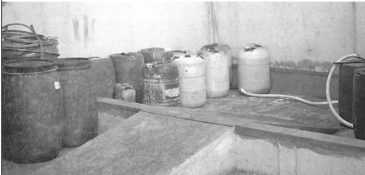
**FIGURA C** - Bacino di contenimento per fustini.
